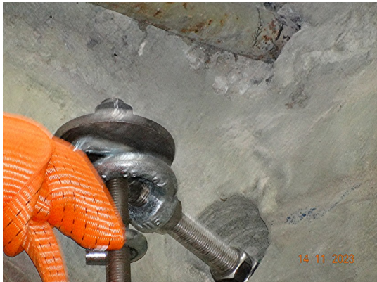
Verankerung der Notsicherung im Mauerwerk
