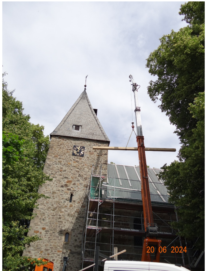
Durch diese enge Dachöffnung wurde der Balken eingebracht.
